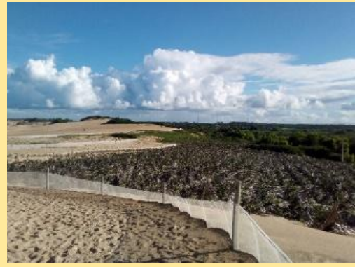
Vista da área revegetada sobre as dunas, para a contenção do avanço da areia.
