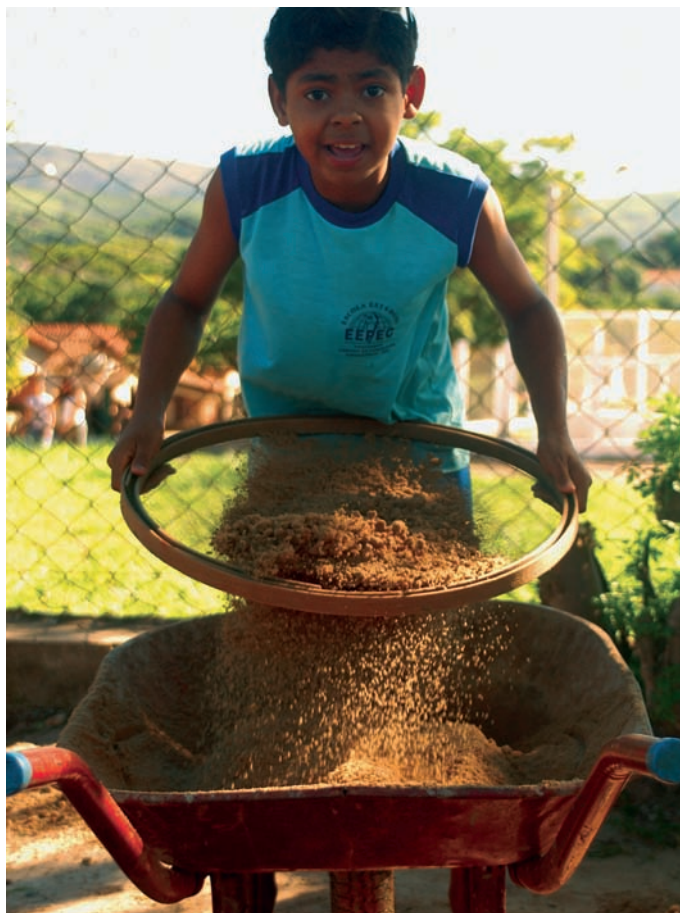
Estudante peneirando areia para a construção do habitat.
