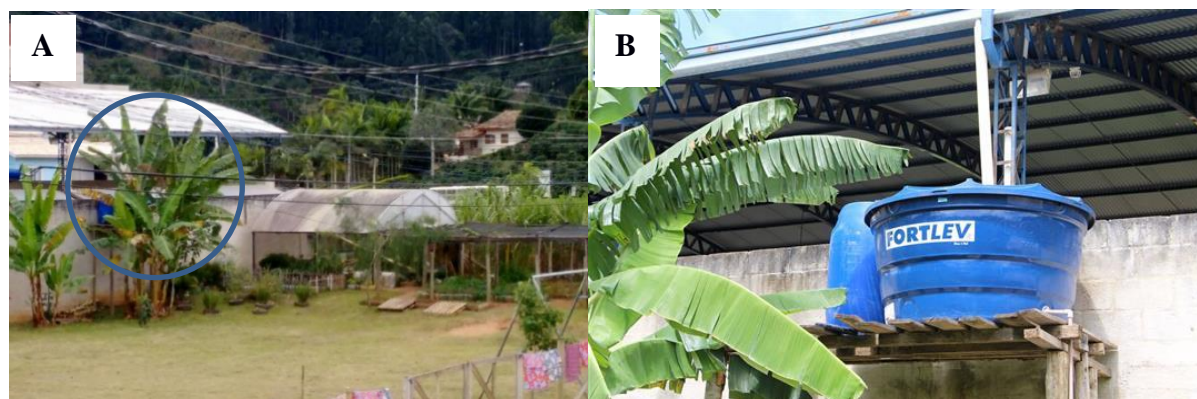
Figura 19 - Área da escola destinada a implantação de ações para a educação ambiental. Detalhe de uma das caixas, utilizadas para a captação de água pluvial
