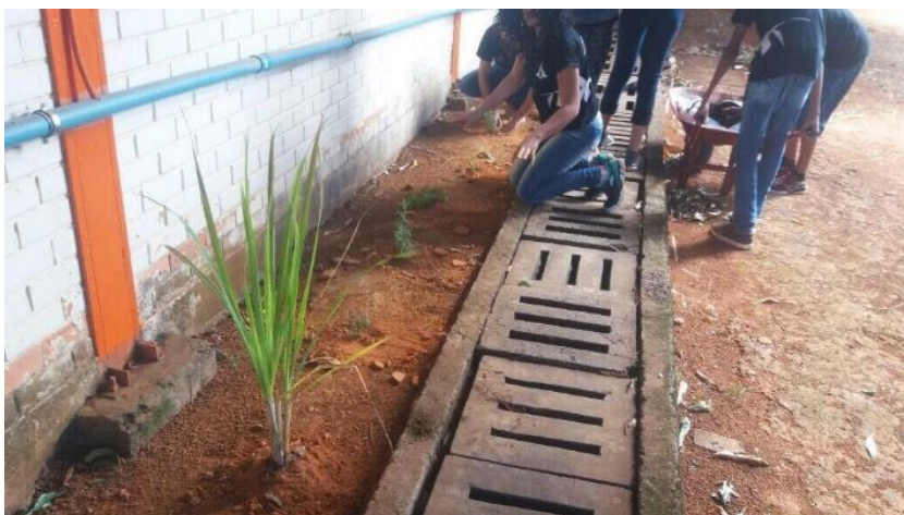
Figura 9.2: Canteiros repelentes em construção com plantas bioativas.
