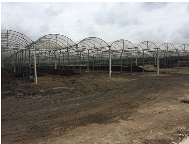
Figura 4 - Vista geral da planta de compostagem da ETE Jundiaí
