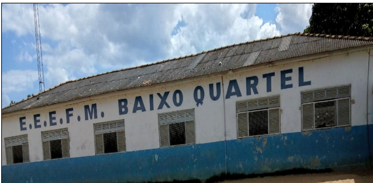
Figura 2 - Fachada da EEEFM. Baixo Quartel
